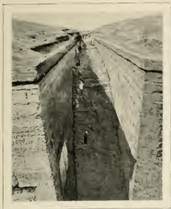
FIG. 78. — LA TRANCHÉE DESCENDANTE A ZAOUÏYÉT-EL-ARYAN. (Cliché Oropesa.)
